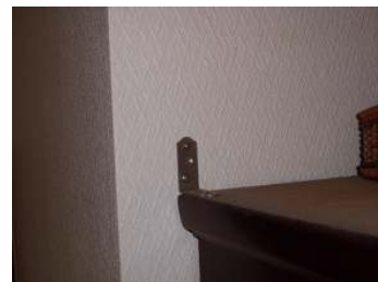
ベルト式による付け替居への固定
